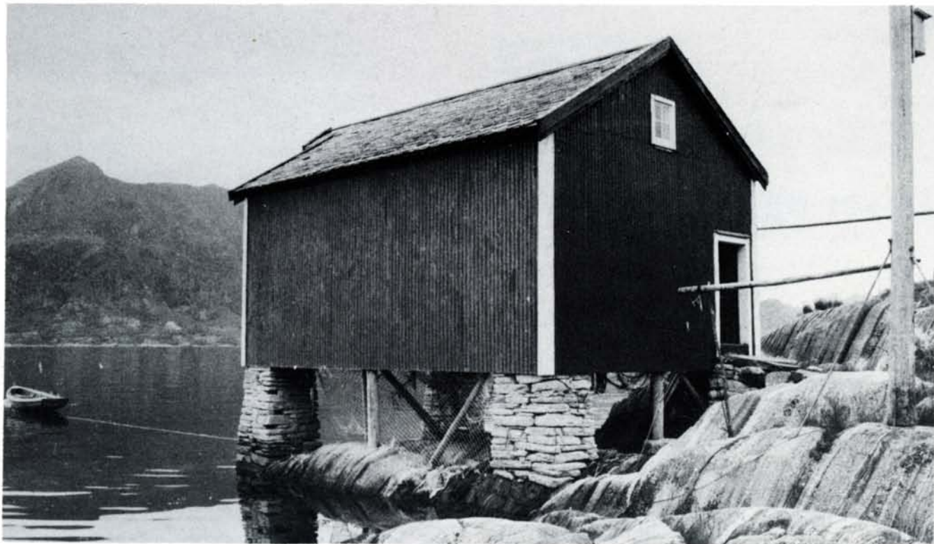
Brygge på Seines, bygd ca. 1890. Huset hadde opprinnelig torvtak, men det ble byttet til skifer i 1924. Huset har grindkonstruksjon og står på pilarer av stokker og naturstein. Steinen til pilarene er tatt ut av svabergelike i nærheten. (Foto: Per Almås).
