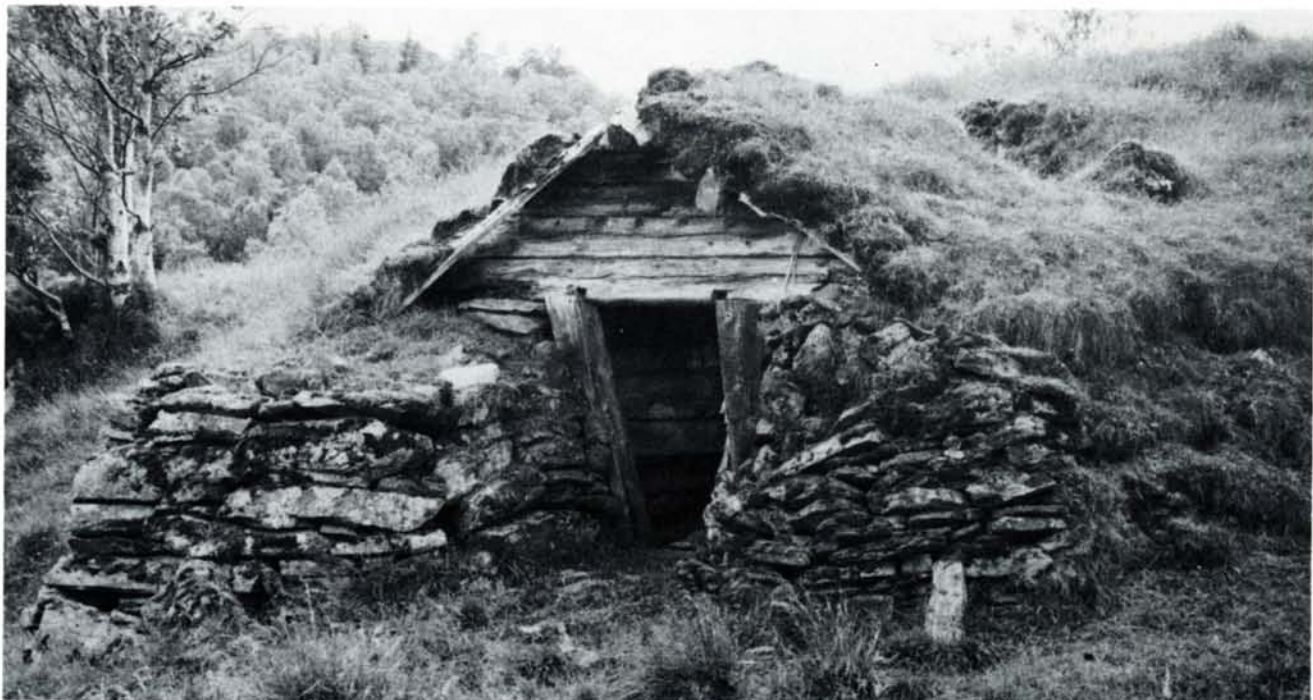
Jordkjeller på Tølløkken. Kjelleren ble bygd på begynnelsen av 1800-tallet og ble brukt til lager for poteter og grønnsaker. Kjelleren er bygd inn i en haug og veggene og gulv er i naturstein. Øvre delen av fasaden er i tømmer. (Foto: Per Almås).
