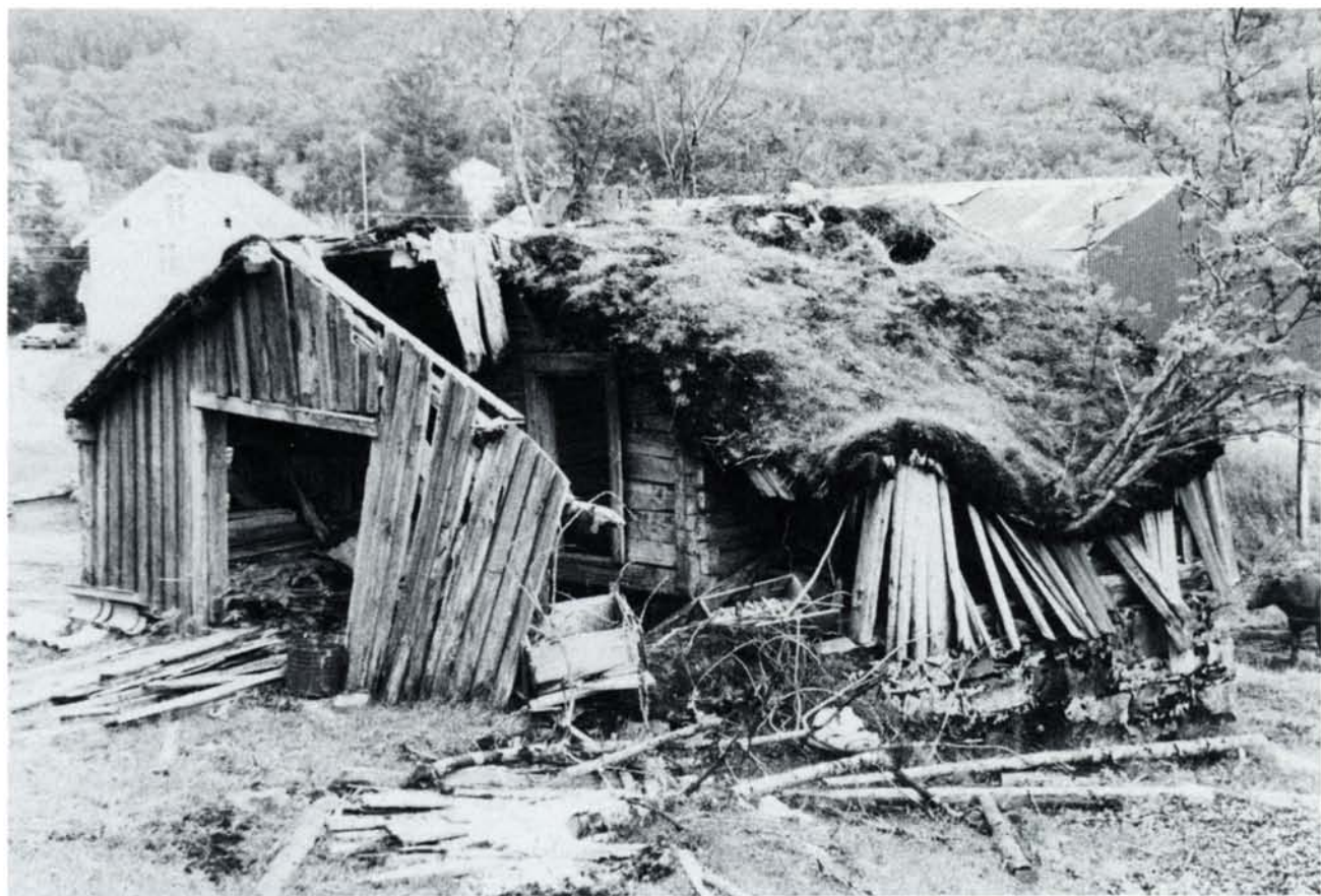
Eldhus (arbeidsstue) på Innergården på Tjong. Huset ble bygd 1860 – 1870 og var opprinnelig mye større bl.a. med stort kjøkken, stue, gang og to stabbursrom. I kjelleren er det eldhus med inntakt gruve, oppe er det stabbur i laftverk og svaler i bindingsverk. (Foto: Per Almås).
