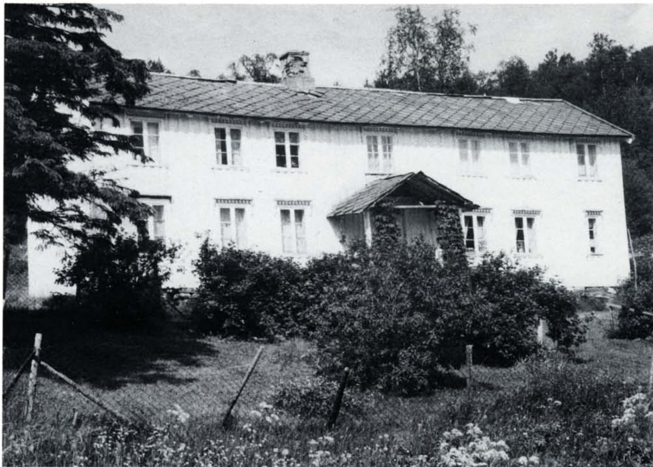
Hagevikgården i Kila. Den eldste delen av huset skal være over 200 år gammel. Huset ble påbygd ca. 1880. Hele huset er laftet. I kjøkkenet er hatten til den opprinnelige gruva inntakt. I stua er taket rose malt. Huset brukes nå til feriebolig. (Foto: Per Almås).
