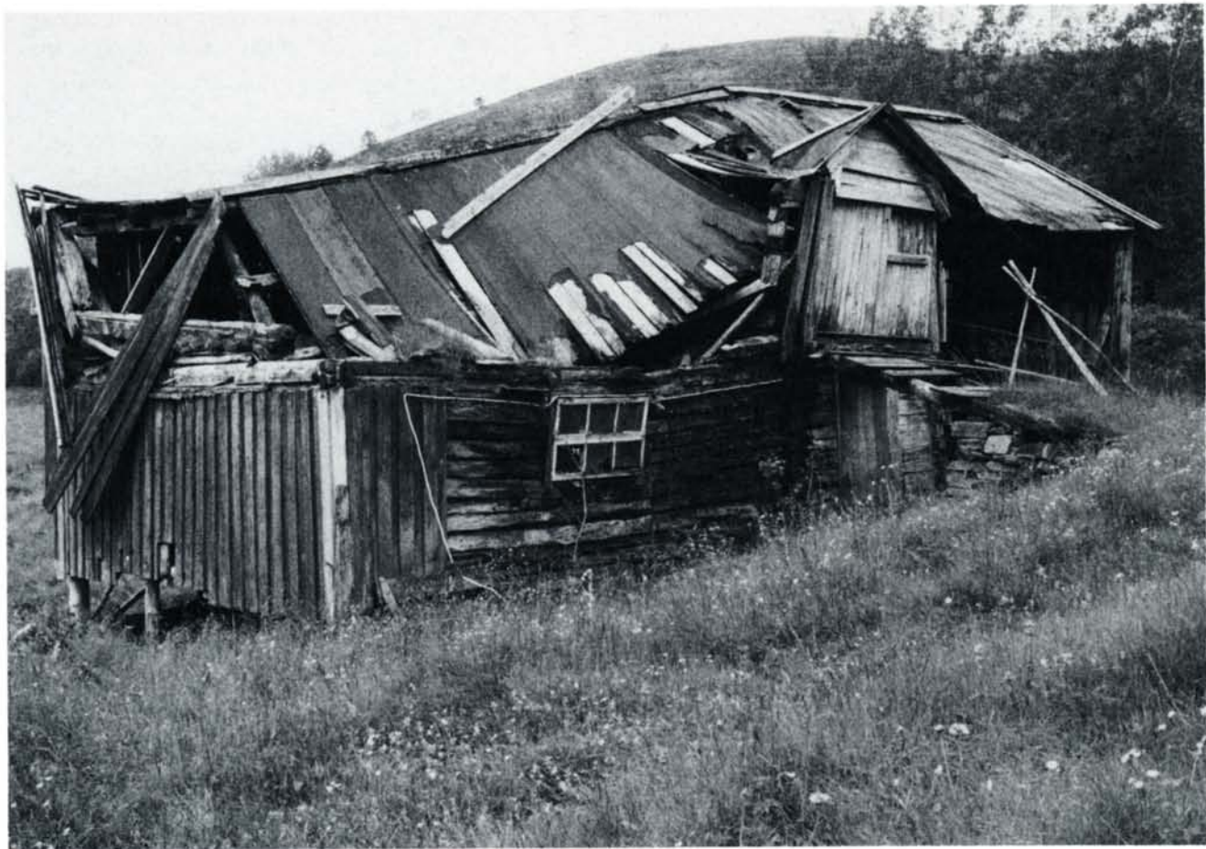
Fjøs på Våga. Huset er bygd ca. 1890 og er nå sterkt forfallent. Byggemåten er tradisjonell; lafteverk i stall og fjøs, bindingsverk i høysvale og låve. Huset står på trepilarer. (Foto: Per Almås).
